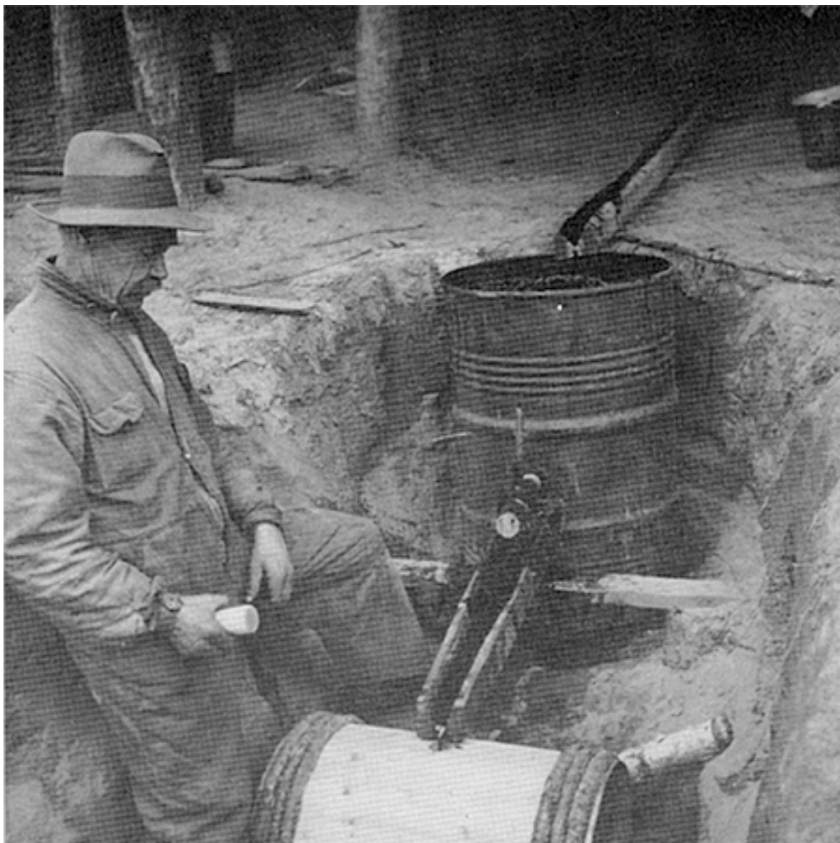
Tjäran avtappas genom en ränna från dalens centrum. Vid tjäruttaget tjänstgör ett bensinfat som magasin, varifrån tjäran tappas i tunnan. Askilje, Degerfors kn. 1936 Foto. V Lundgren, STF:s bildarkiv
