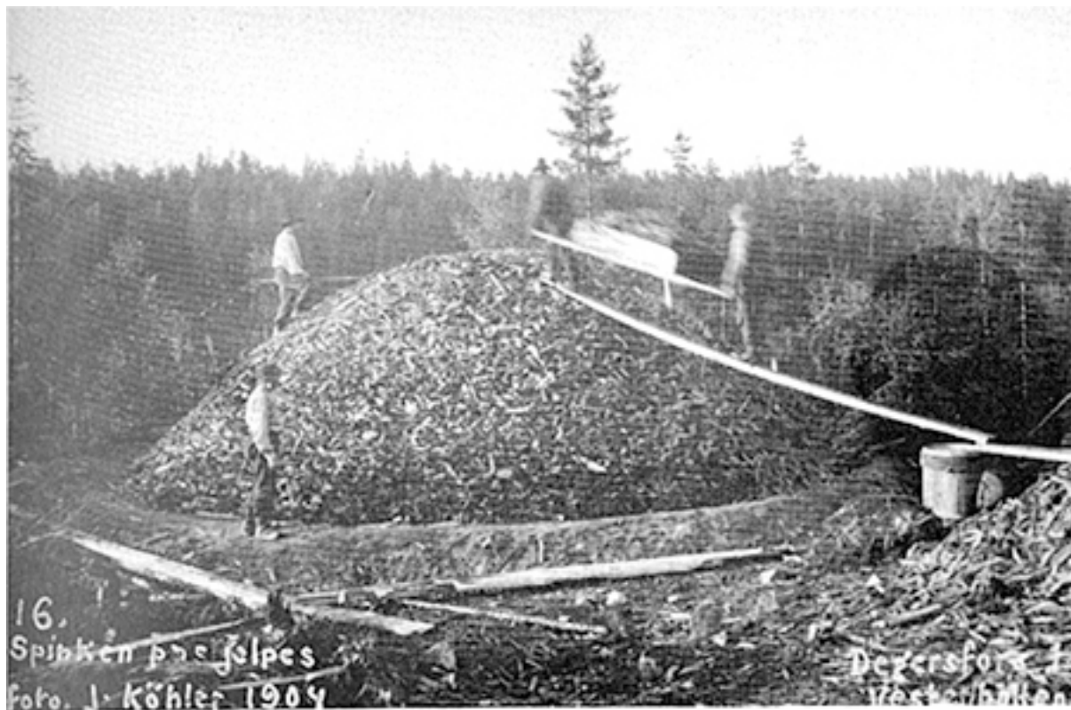
Småveden - spinken - påstjälpes. Degerfors kn. Sekelskiftet Foto. J Köhler, Nordiska museet
