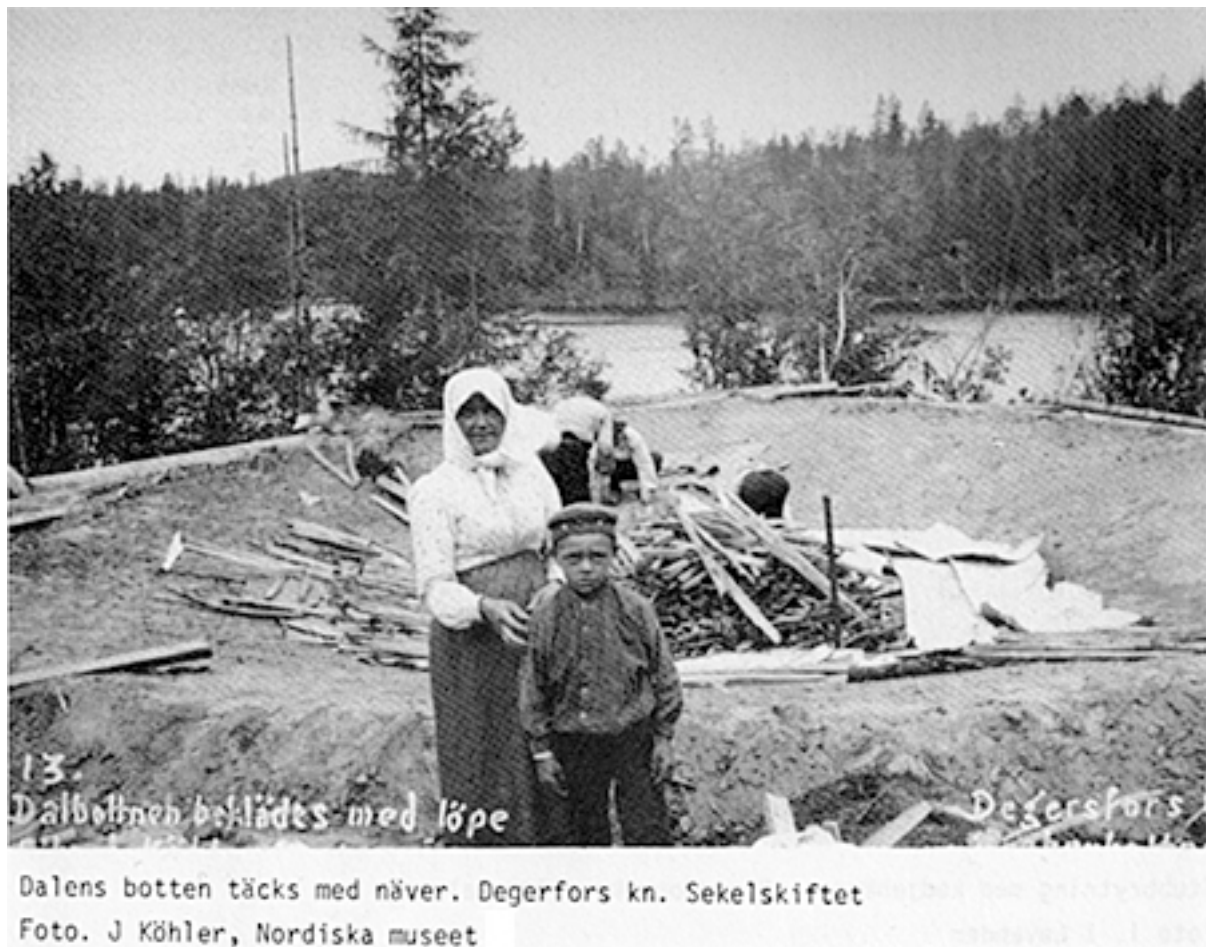
Bild 14. Tjärdalens botten täcks med näver.
