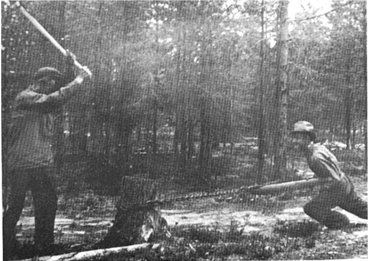
Stubbrytning med kedjehävtyg. Degerfors kn. 1930-talet Foto. I Levander
